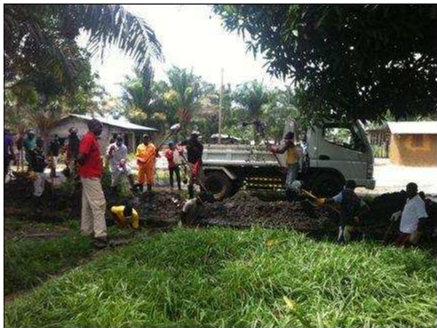
L'association Mboka Bopeto au cours d'une opération de curage des canalisations à Owando.
