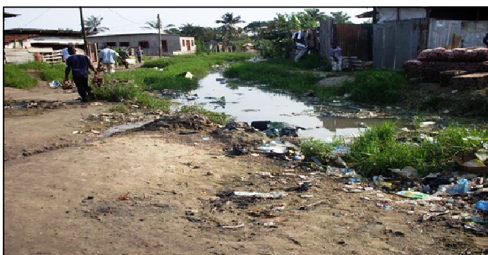
Ruelle fortement dégradée qui sert de canal d'évacuation de l'eau au quartier 110 (1 er arrondissement de Pointe Noire)
