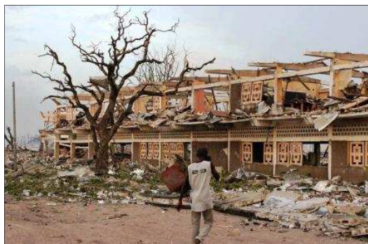
Ce qui reste du lycée de la Révolution à Ouenzé
